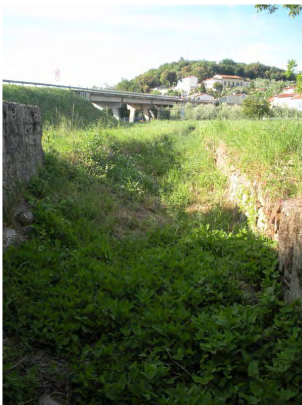
Gora di Gora ormai invasa dalla vegetazione e viadotto della superstrada di Via Bolognese.
