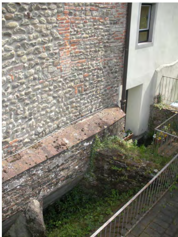
Dettaglio del canale di adduzione dell'acqua, dal bottaccio ai locali inferiori dove alloggiava la ruota idraulica(ritrecine) collegata alla macina.
