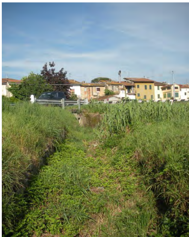
Tracciato della gora di Gora appena a valle del partitoio, nell'area del raccordo della superstrada e retro delle abitazioni di Via Modenese (Capostrada).
