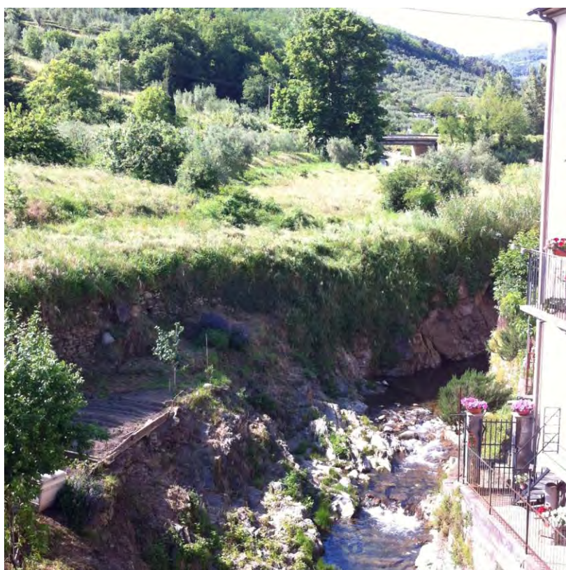
Veduta del ponte di Via Crespole e Fabbriache (dove nasce la gora di Candeglia), dal ponte di Via Santomoro e Valdibure, sulla curva appena prima dell' eremo dove si ritirava, stando alla tradizione, san Felice.
