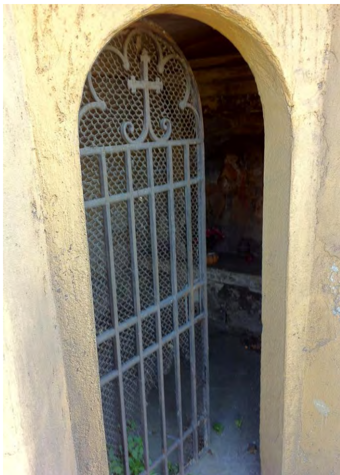
Via Valdibure e Santomoro, piccola cella di meditazione e preghiera di san Felice, nell'edificio a monte del ponte sulla Bure
