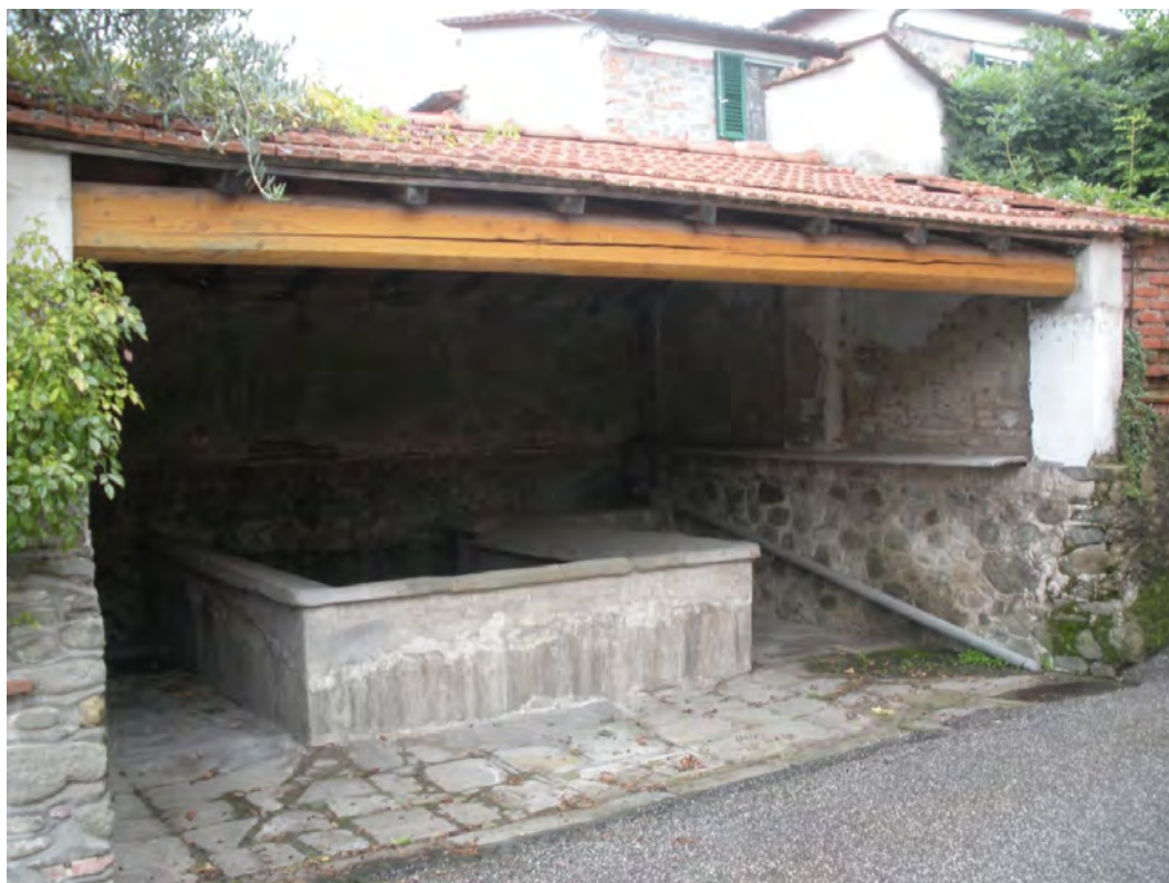
Lavatoio di Candeglia all'incrocio tra Via della Filanda e Via Carota e Molina, a 50 metri dal circolo.
