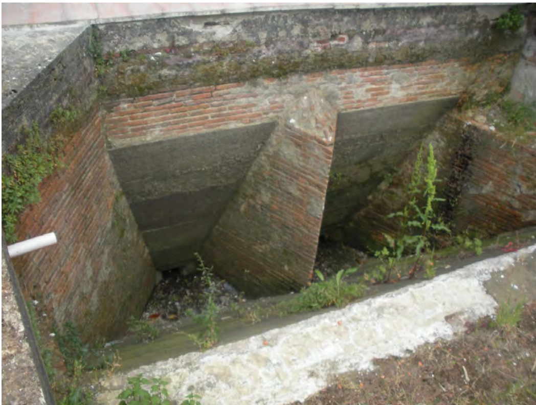
Tromba del bottaccio, in collegamento, tramite un piccolo orifizio sul fondo, con le pale in legno del ritrecine o ruota idraulica.
