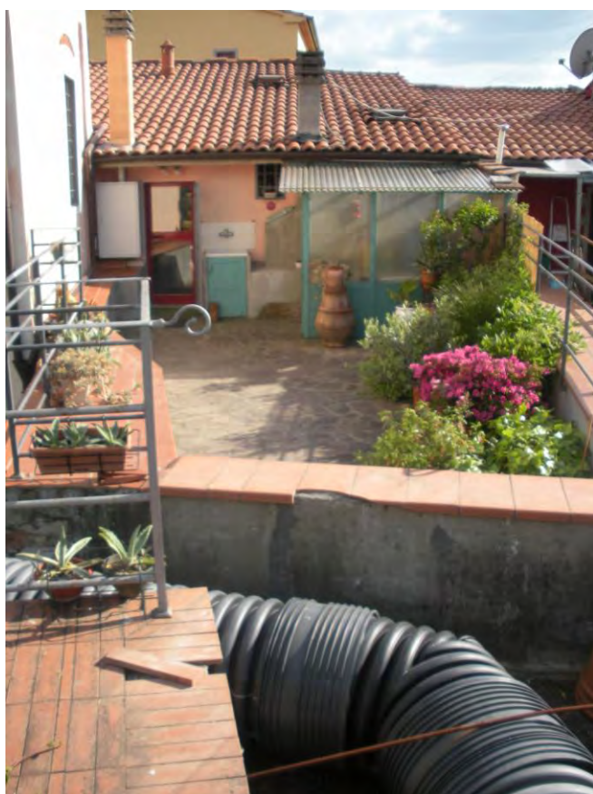
Bottaccio riconvertito a terrazzo e deviazione della gora con bypass laterale verso i locali ipogei, da cui l'acqua riprende il suo corso.
