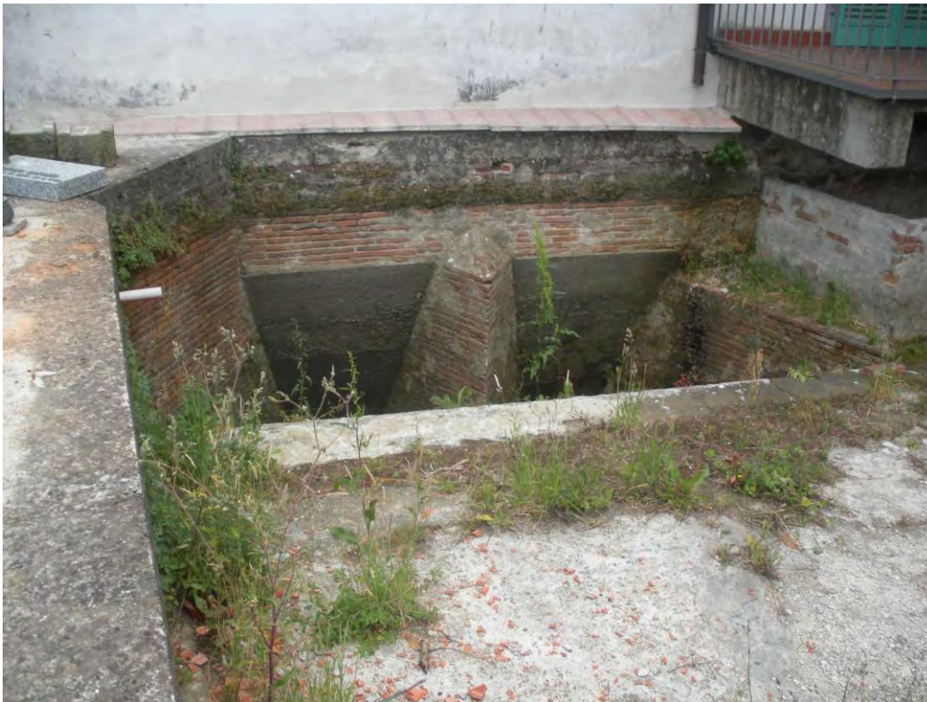
Dettaglio strutturale della vasca e della tromba del bottaccio.
