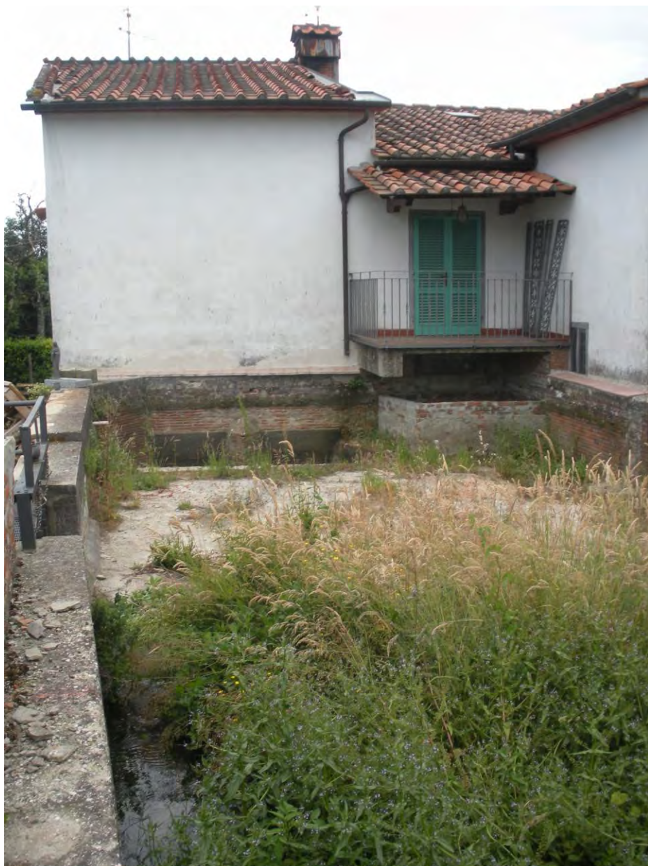
Particolare del bottaccio della famiglia di Mario Ghelardini, in uso fino al 2013. L'acqua, quando la gora è in funzione, viene deviata lateralmente e convogliata nei locali ipogei del ritrecine in modo che non vada a riempire la vasca e la tromba del bottaccio.
