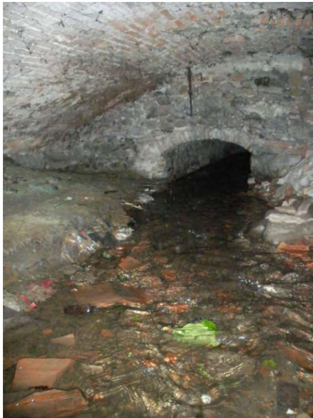
Dettaglio dei locali ipogei della struttura da cui passa la gora.
