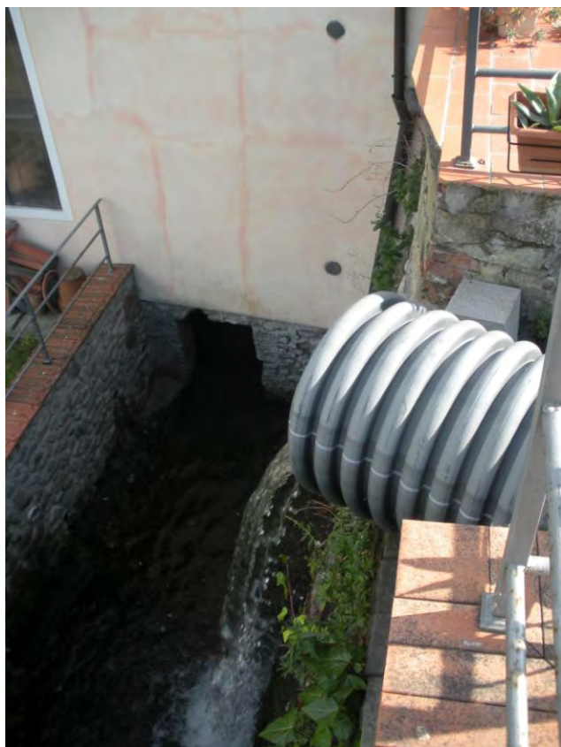
Dettaglio del bypass laterale che devia le acque della gora dall'ex bottaccio, ora trasformato in terrazzo.
