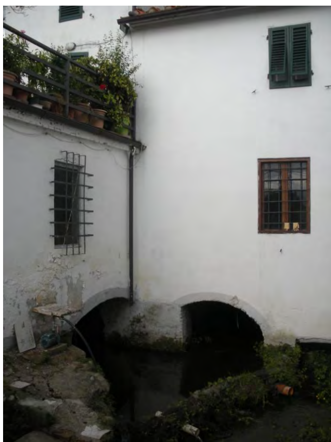
Sbocco dai locali ipogei.
