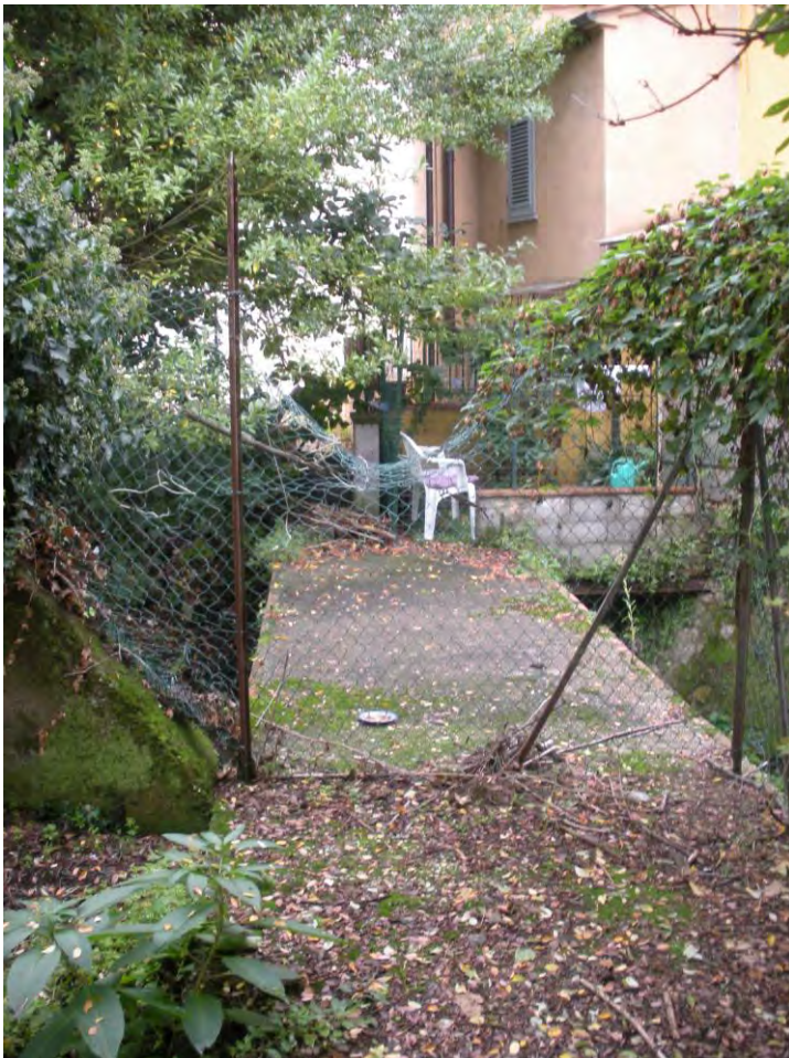
Resti dell'antica struttura del ponte canale sul Diecine, tra Via Nerucci e Via Sestini.
