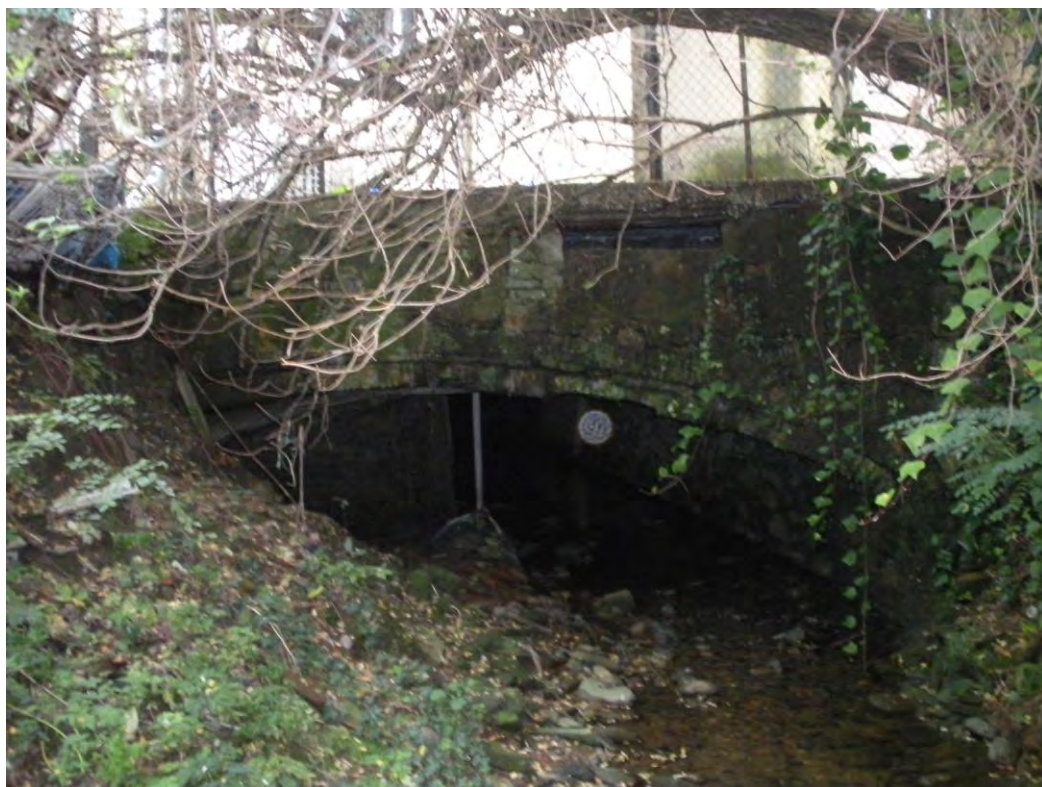
Resti dell'antico ponte canale sul torrente che viene da Via di Bigiano e Castel dei Bovani e confluisce nel Diecine. Gli edifici sul retro sono quelli di Via Tripoli.
