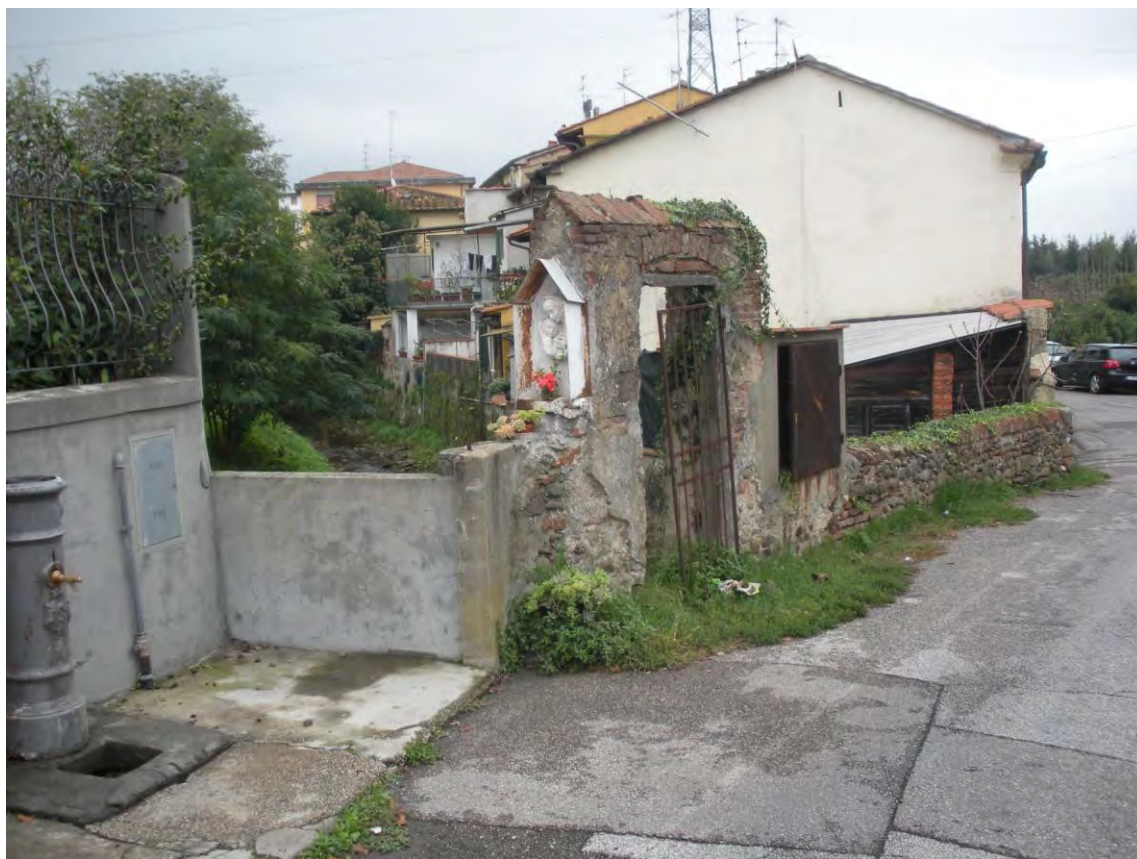
Via Nerucci, ponte sul Diecine e cancellino decadente, in tutti i sensi. Si noti la Madonnina ed il tratto di gora coperto, sulla sinistra, proprio sotto la fontana. Da qui la gora procedeva al ponte canale sulla Brana bombardato nella seconda guerra mondiale e definitivamente perduto.
